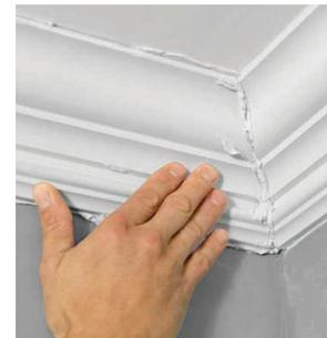
4. Соедините оба карниза вместе, чтобы их профили совпали. Используйте остатки клея, чтобы замазать трещины между карнизами.
