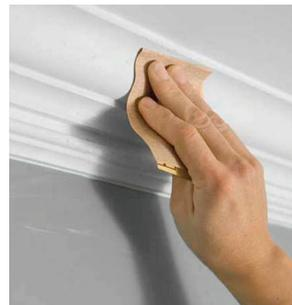
7. Для шлифовки поверхности используйте наждачную бумагу.
