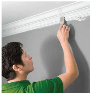
6. С помощью ножика для заделки швов, обработайте стыки карнизов.
