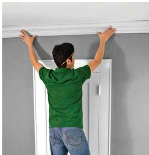
1. Сделайте отметки карандашом на стене, чтобы определить местоположение карниза.
